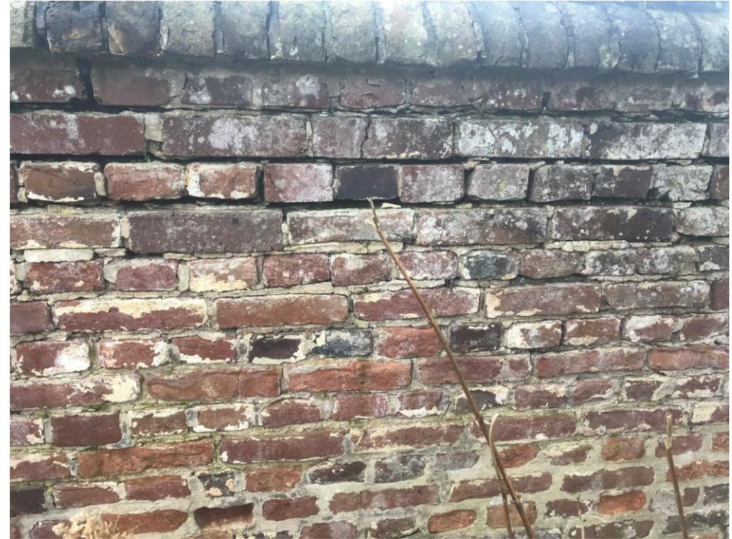
Reprise de certains jointements et fissures constatés sur la totalité de l'ouvrage.
