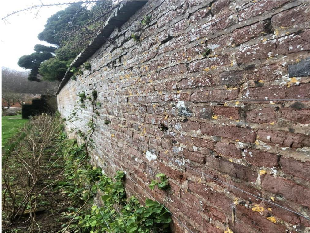
Nécessité de renforcer le mur à certains endroits. Il a tendance à s'affaisser (exemple ici du mur du potager)
