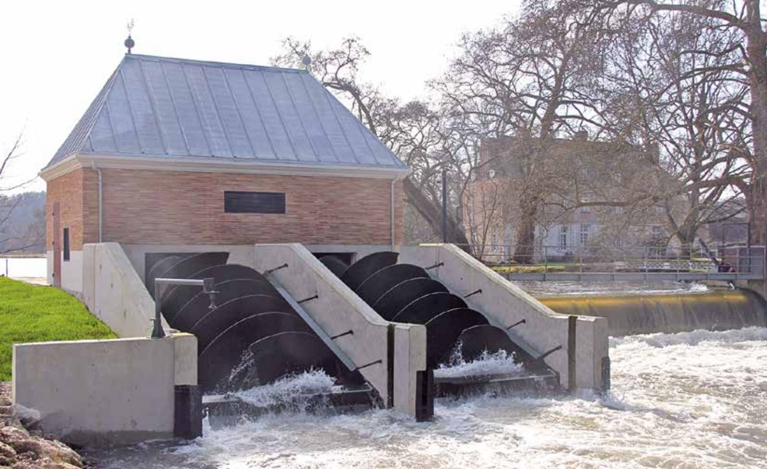
▲ Les deux turbines.
