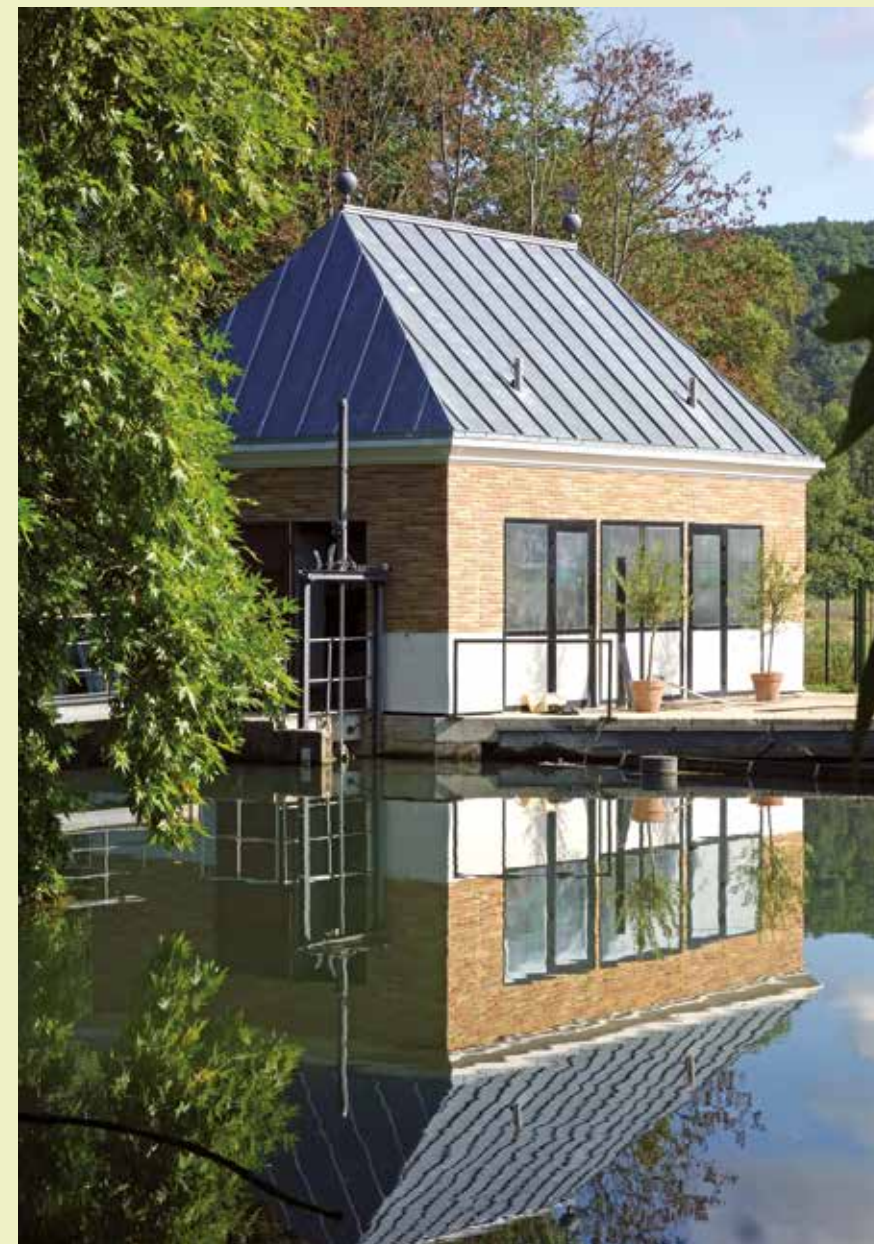
▲ Le bâtiment des alternateurs.
